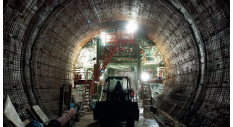
Abbildung 2: Gewölbeschalwagen bei Betonage (Foto: DB InfraGO AG)
