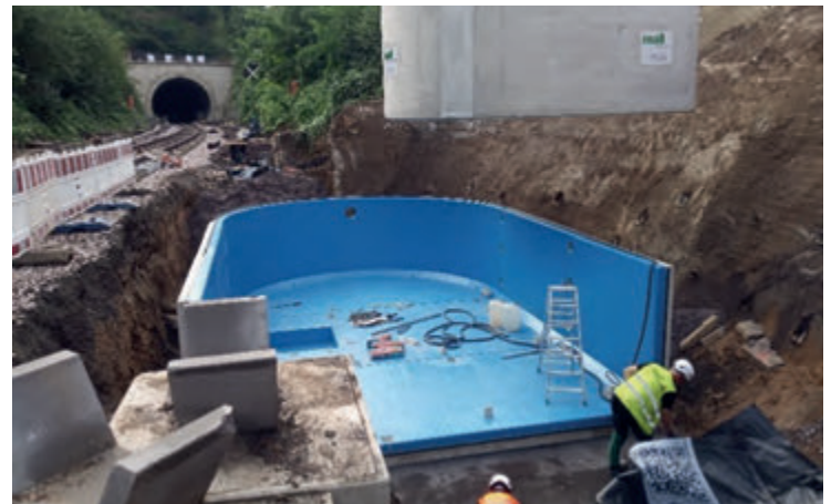
Abbildung 6: Fundament Technikgebäude (Foto DB InfraGO AG)
