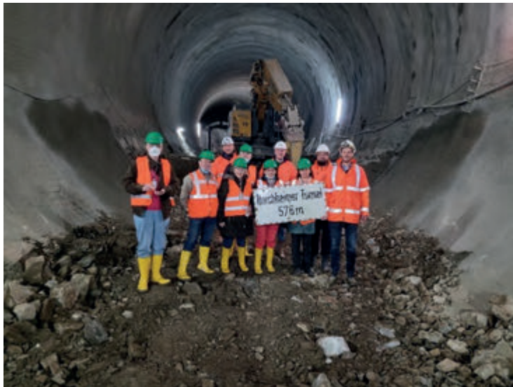
Abbildung 7: Übergabe altes Tunnelschild an die Heimatfreunde Horchheim e.V. (Foto: DB InfraGO AG)
