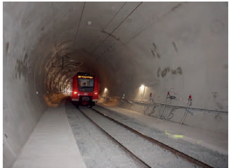
Abbildung 10: Neuer Horschheimer Tunnel (Foto: DB InfraGO AG)
