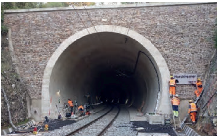
Abbildung 8: Montage des neuen Tunnelschildes (Foto: DB InfraGO AG)
