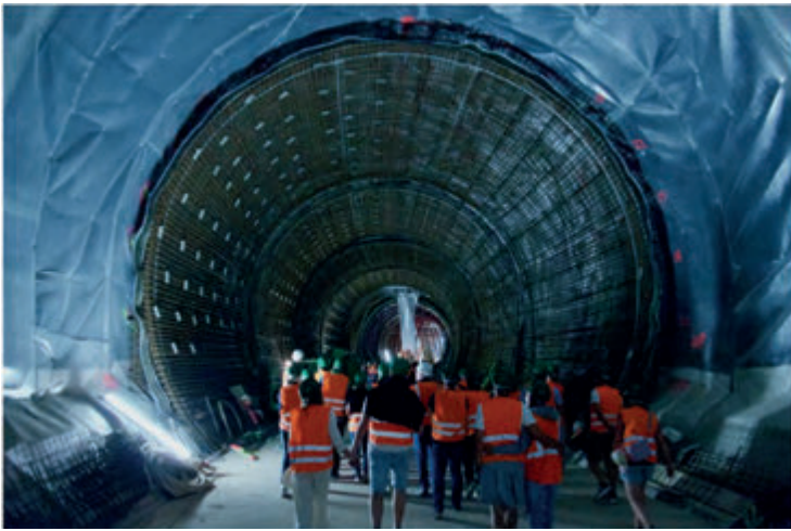
Abbildung 4: Tag des offenen Tunnels (Foto: Heimatfreunde Horchheim e.V.)
