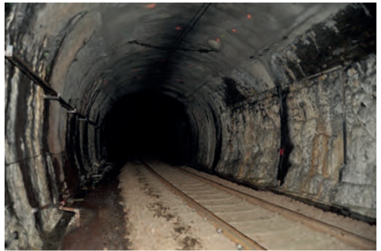
Abbildung 9: Alter Horschheimer Tunnel (Foto: DB InfraGO AG)
