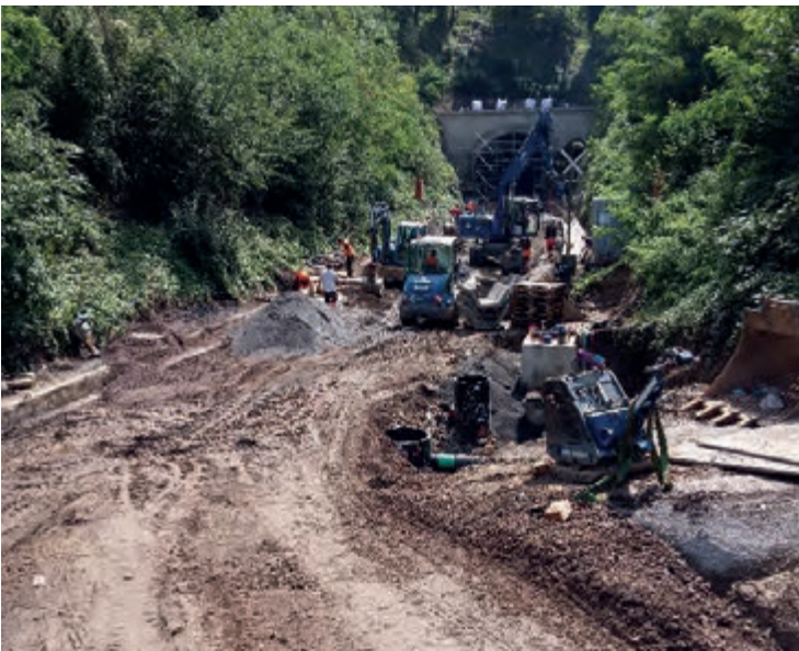
Abbildung 5: Erd- und Tiefbau Voreinschnitt Nord (Ravensteynstraße) (Foto DB InfraGO AG)
