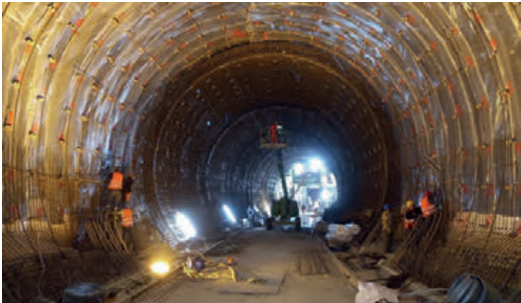
Abbildung 1: Einbau der Stahlbewehrung im Tunnelgewölbe (Foto DB InfraGO AG)
